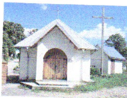
Kaplica cmentarna w miejscowości Słupia
